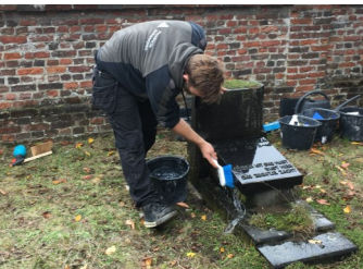
Stap 3: nat maken en sopje aanbrengen met borstel
