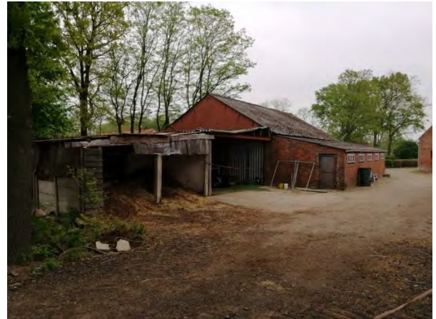
Foto 2: schuur en garages
